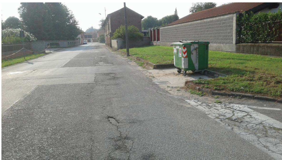
Via Pisacane – carreggiata da Borgolavezzaro – stato di fatto strada e cordoli
