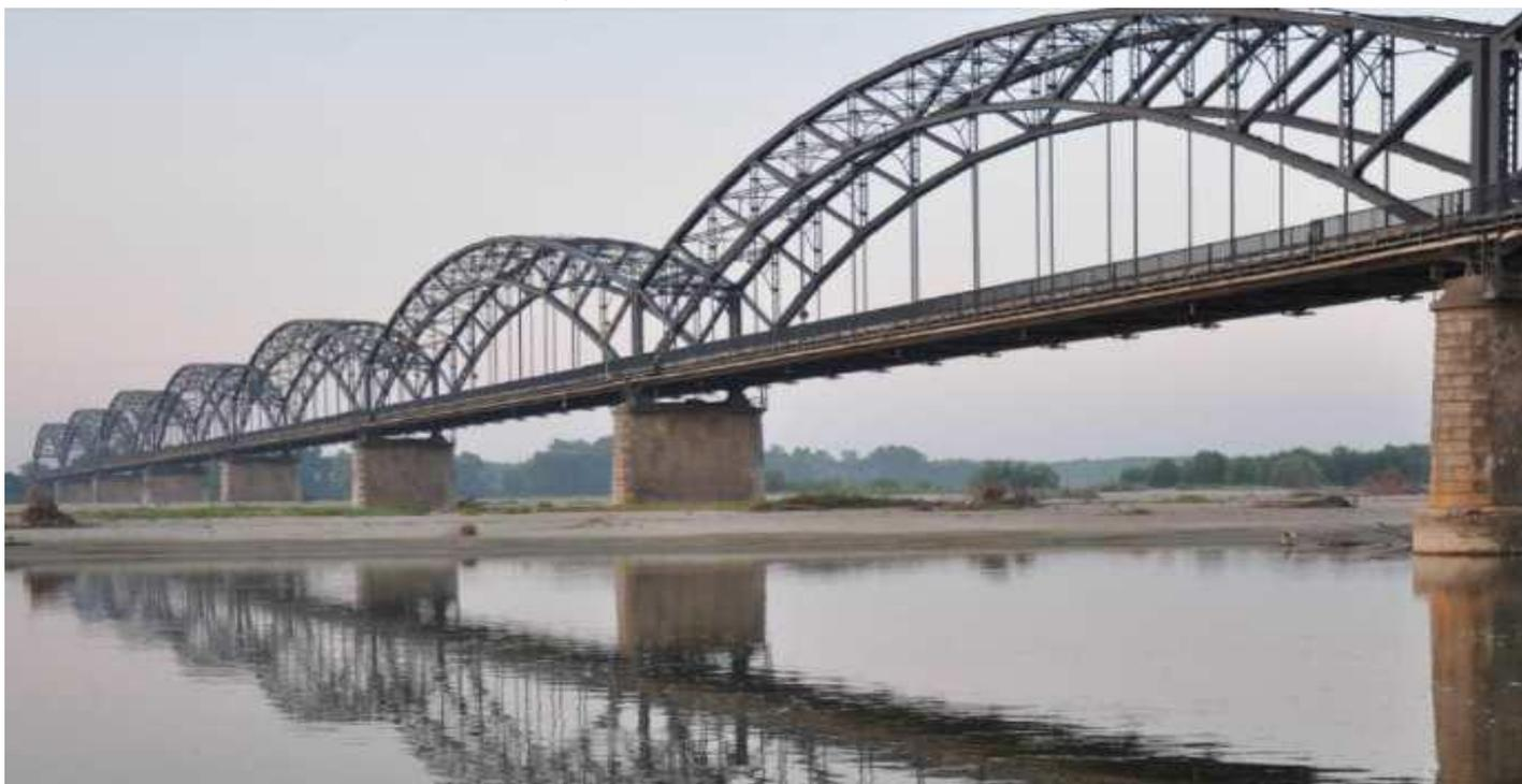
Il ponte è costituito da 8 campate, ciascuna con lunghezza di 93,00 metri tra gli assi degli appoggi, con interasse tra gli appoggi sulla pila di 1,08 m. e sulle spalle di 2,12 m., per un'estensione totale del ponte di 755,80 metri.
