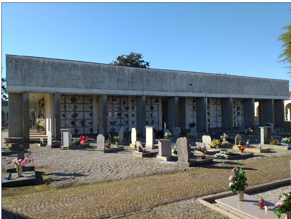
Vista Sud - Est Fabbricato oggetto d'intervento
