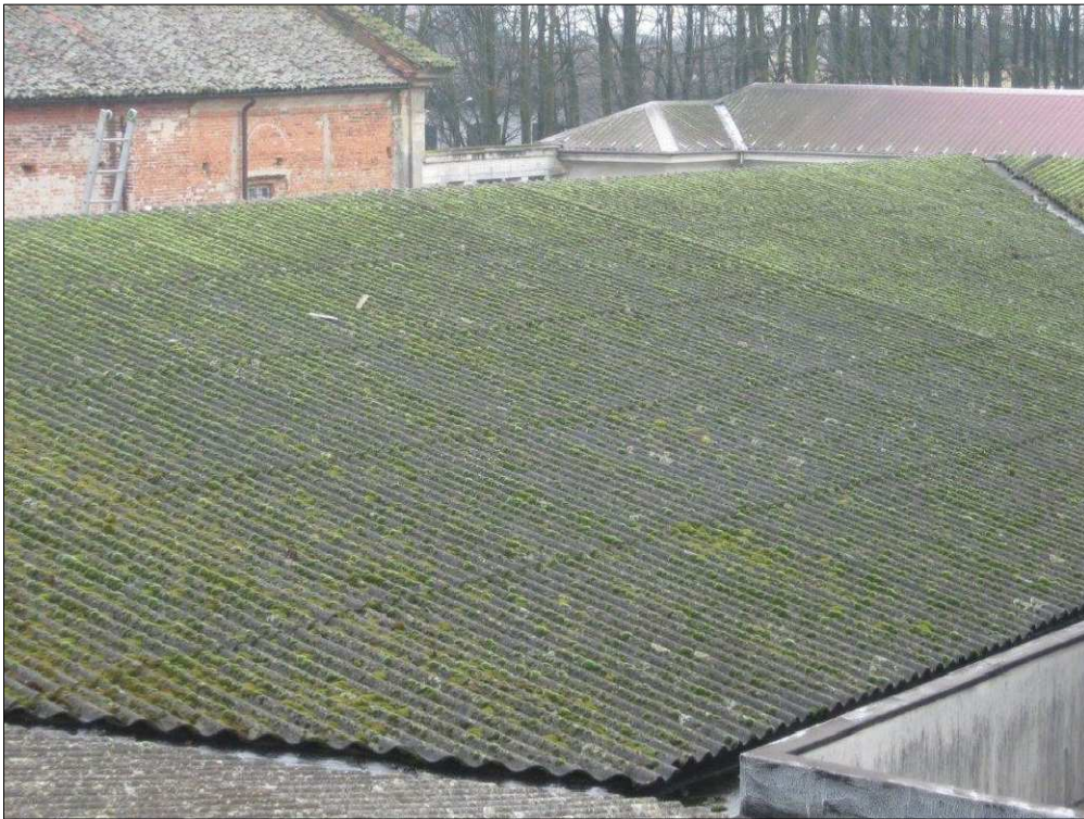
Vista particolare copertura Fabbricato oggetto d'intervento
