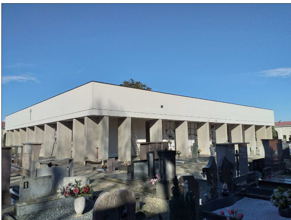
Vista Sud - Ovest Fabbricato oggetto d'intervento
