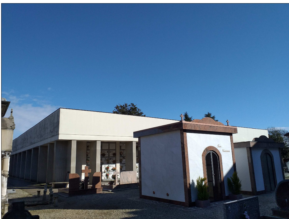
Vista Nord - Ovest Fabbricato oggetto d'intervento
