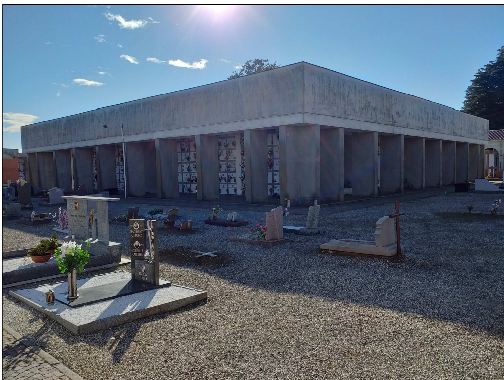
Vista Nord - Est Fabbricato oggetto d'intervento
