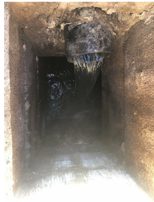
Pozzetto Fognatura
