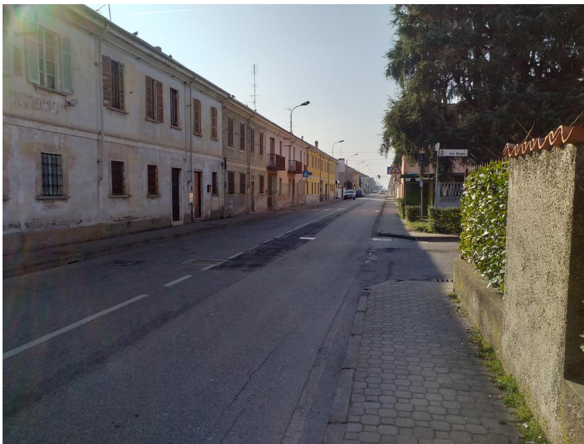
TRATTO A-B C.so Roma - stato di fatto manto stradale
