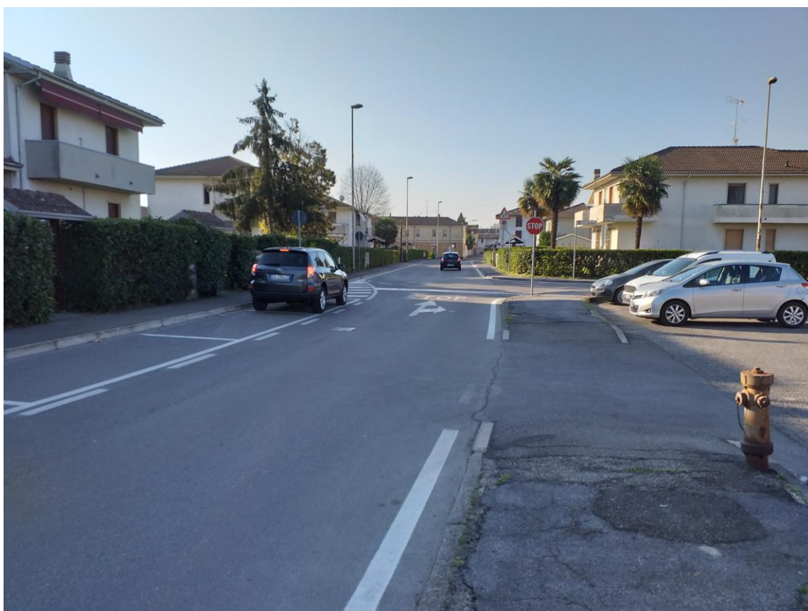
Via Togliatti - stato di fatto tratto interessato da realizzazione attraversamento pedonale rialzato
